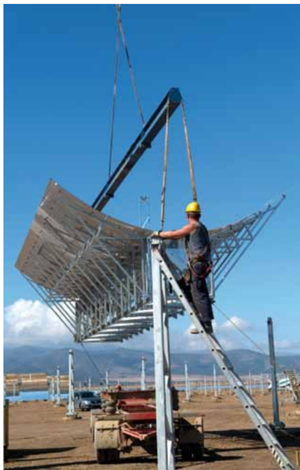
Simpele technologie. In het brandpunt komt de buis die verhit wordt. De hete vloeistof daarin wekt stoom op voor de turbine.
