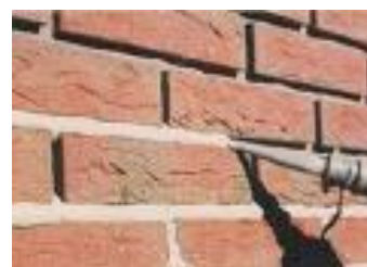
Afbeelding 15 – Spuiten van voegen met kalkmortel
